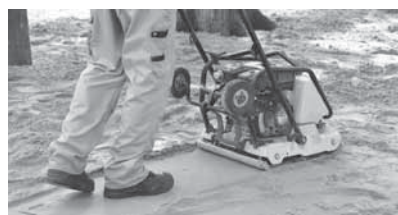
Verdichten van de bodem
