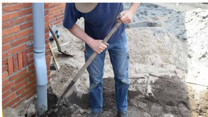
De regenpijp van het dak wordt uitgegraven om hem af te koppelen van het riool.
