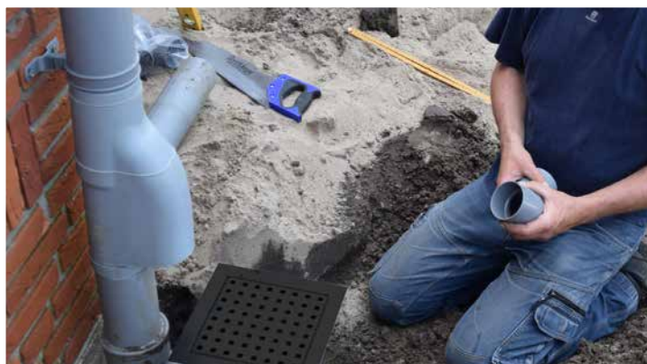
Op de regenpijp wordt een loofscheider gemonteerd, die er voor zorgt dat er geen grof vuil zoals blad in de zandvangput terecht komt.
