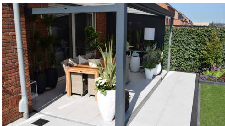
Op deze foto ziet u drie aansluitingen die zijn aangesloten op de Hydroblob BD112 blokken. De regenpijp van het huis, de regenpijp van veranda die weggewerkt is in de staander en de lijnafwateringsgoot langs de bestrating.
