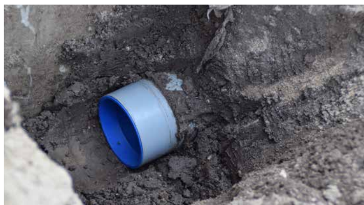
De rioolpijp die nu vrij komt te liggen wordt afgedopt, zodat er geen vuil meer het riool in loopt.
