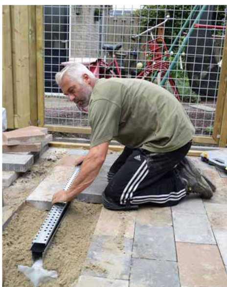
Designrooster plaatst u circa 5 mm lager dan de bovenkant van uw bestrating. Mocht de bestrating later iets verzakken, blijft het regenwater toch het rooster inlopen.
