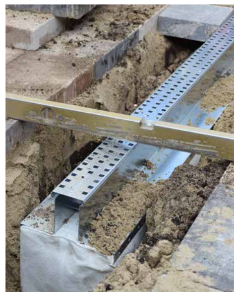
Laat van twee kanten uw bestrating op afschot van minimaal 1 cm per strekkende meter naar de infiltratieblokken lopen.
