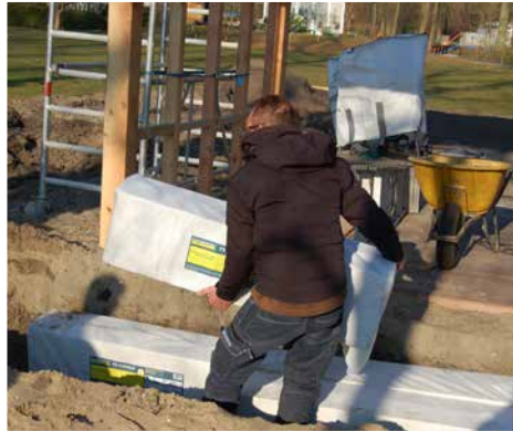
Plaats de Hydroblob® infiltratieblokken rechtopstaand, zo kunnen ze een hogere druk opvangen en infiltreren ze het snelst regenwater.
