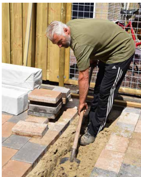
Graaf een gat waarin u de D45 infiltratieblokken plaatst.
