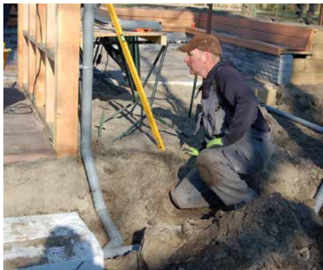
Sluit ook de hemelwaterafvoer van de overkapping aan op de regenpijp.
